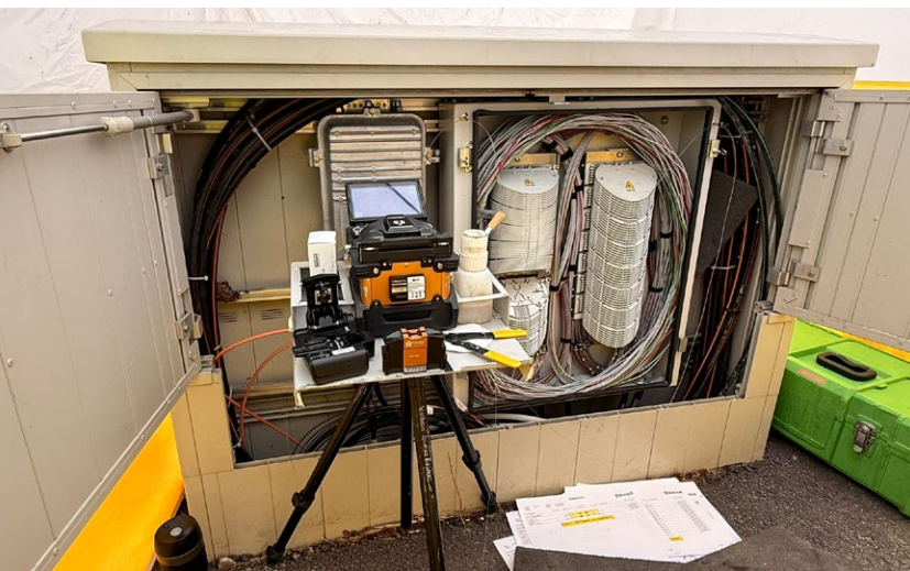
LWL-Verteilkabine mit Spleissgerät
