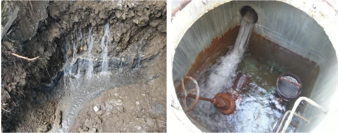
Reschquelle vor der Sanierung 2021 und die Brunnenstube 2014.
